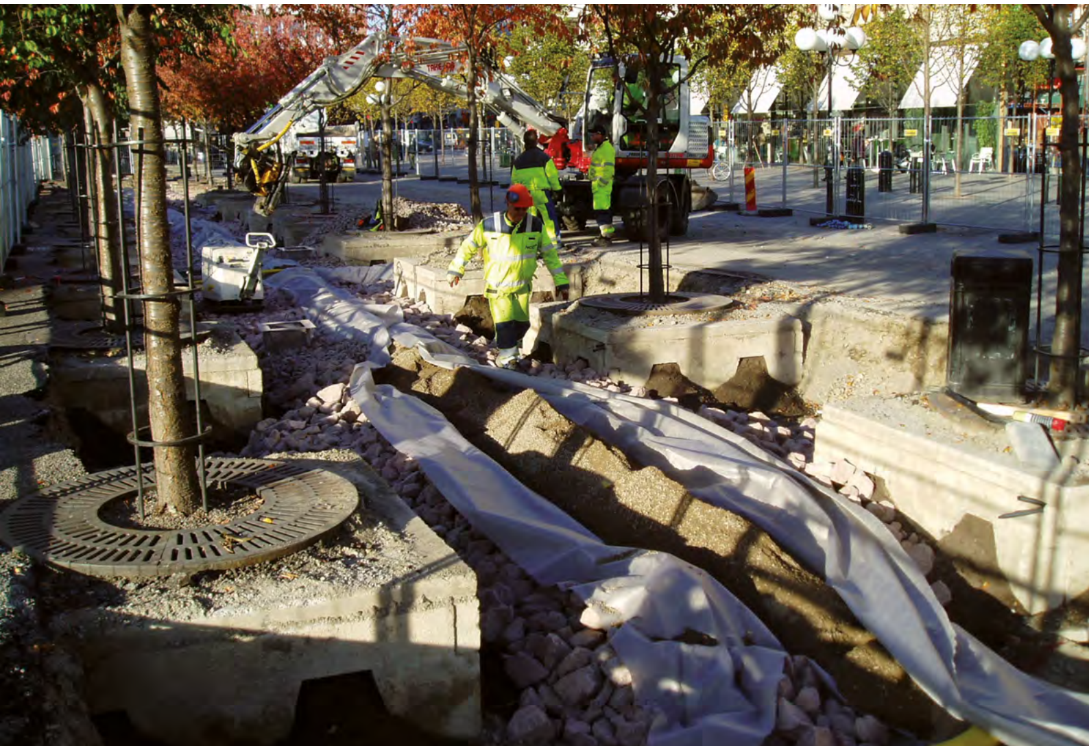
Baumgrube, Wurzelraum und Baumscheibe Stammschutz mit Bodenbelüftungseinrichtung
